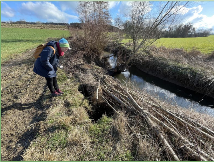
Foto 1-3: Bild von der Zerstörung am Senserbach
