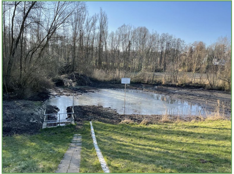
Foto 2-3 Regenrückhaltebecken mit abgelassenem Wasser und Biberburg
