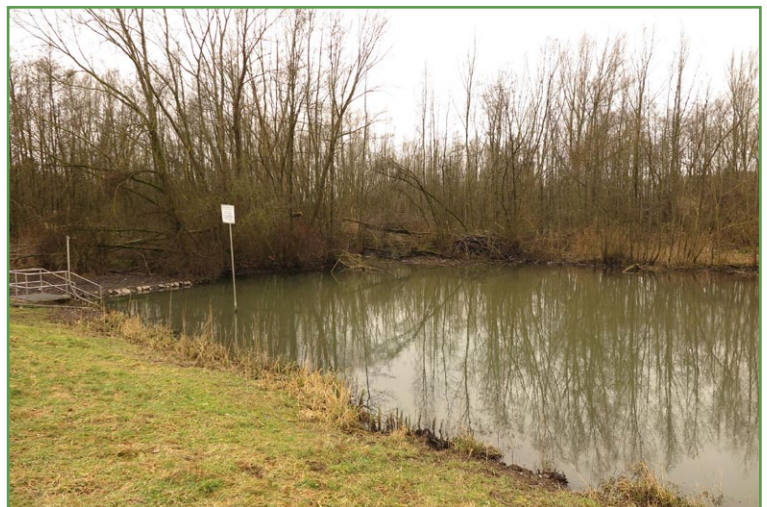
Foto 2-1 Regenrückhaltebecken mit angestautem
