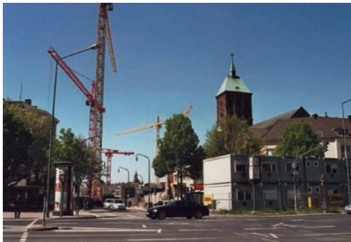
St. Adalbert mit Baustellenhintergrund vom Adalbertsteinweg aus gesehen
