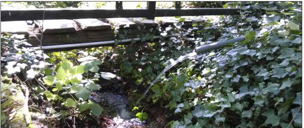
Der oberste Anrainer pumpt das Wasser einer Nebenader, die er bei einer Baumaßnahme angebaggert hatte, über eine Zisterne direkt in den Bach.
