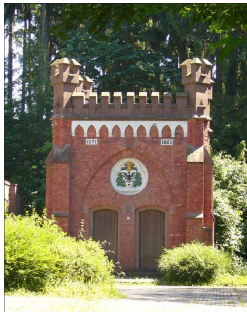
Eingangsbauwerk zum Eicher Stollen (Foto: Frank Suttner)
