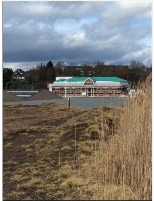
Vielle Montagne - das alte Direktionsgebäude an der Lütticher Straße vorher. ...
