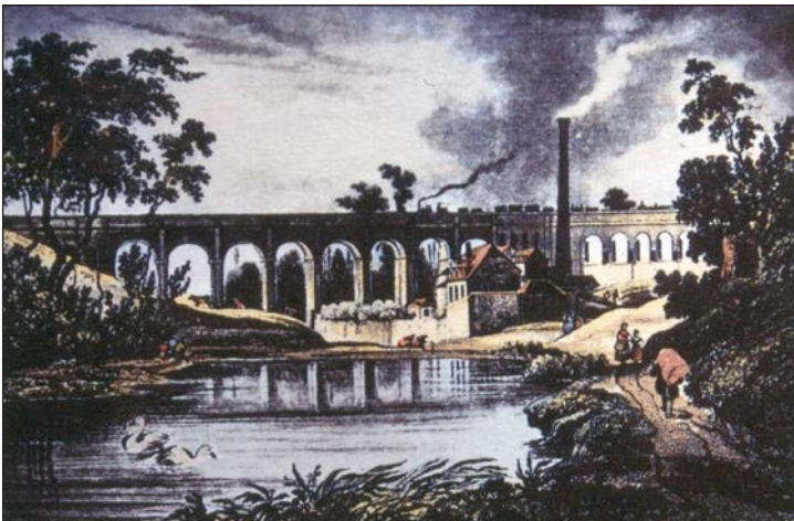
Burtscheider Viadukt mit Kuckartzmühle.
