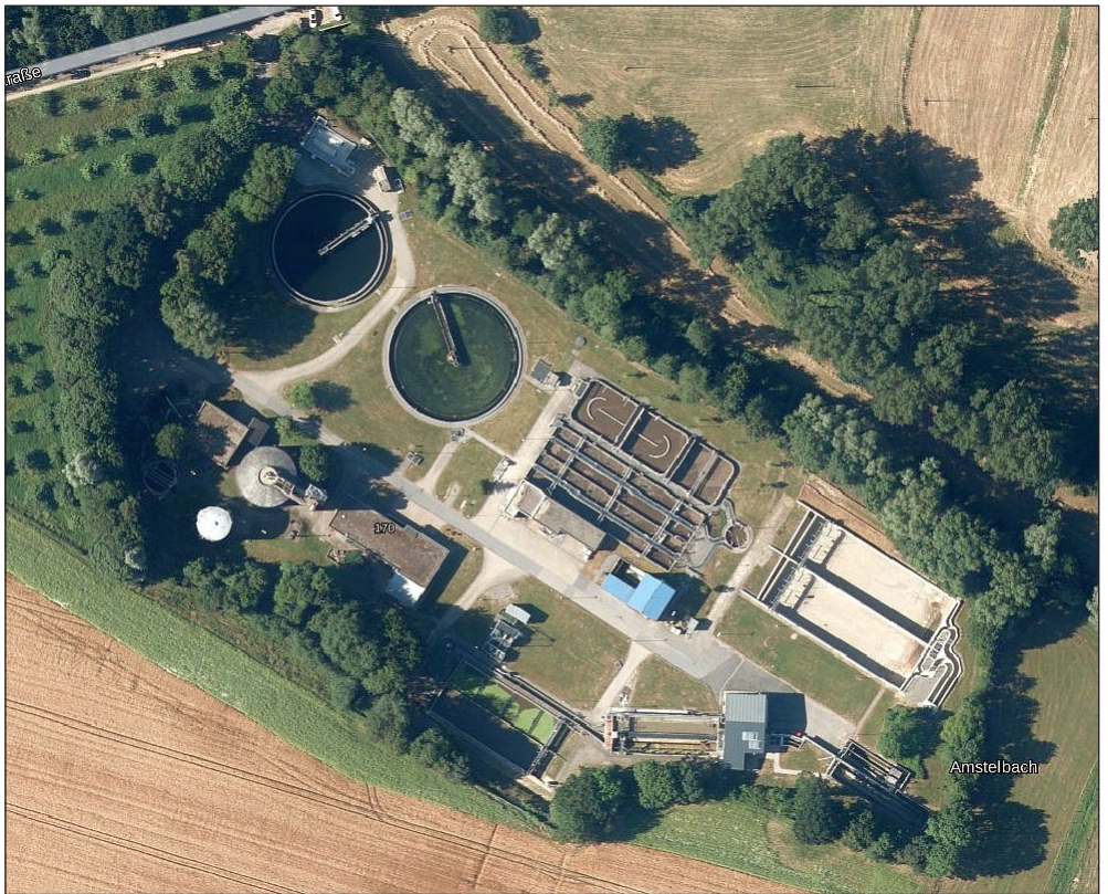
Abb. 12: Kläranlage Horbach im Luftbild (Land NRW (2020) - Lizenz dl-de/zero-2-0 ( www.govdata.de/dl-de/zero-2-0 ))
