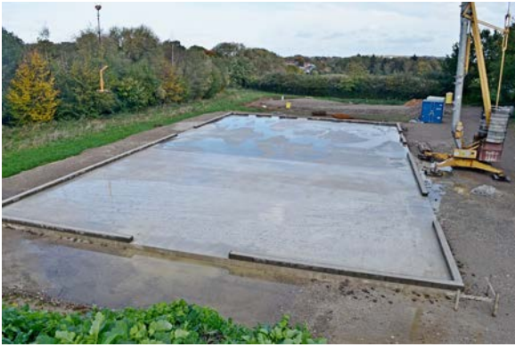
Bild 6: Fertigstellung der Betonbodenplatte für die Gebäude, 28.10.2023
