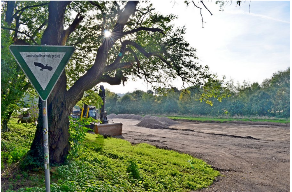
Bild 1: Ungeachtet der Hinweistafel wird hier großflächig gebaut.
