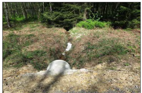
Abb.6: Betonrohr unter der Vennbahn
