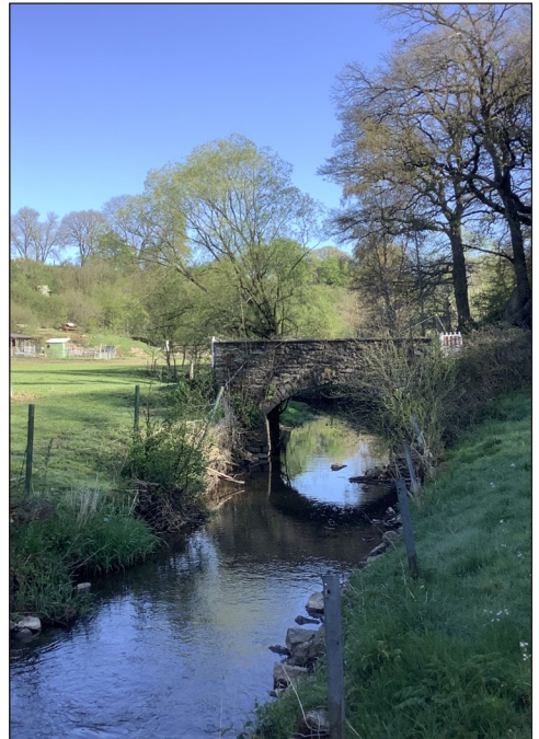
Foto 5: Brücke bei Eisenhütte
