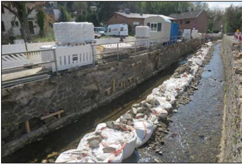
Bild 6: Reparatur an der Ufermauer der Inde
